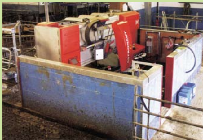
Figura 2: Obra civil para instalar um robot.
